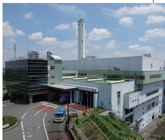
クリーンセンター多摩川 画像提供：多摩川衛生組合
